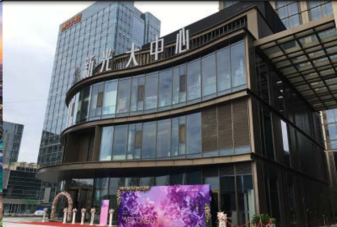
Actual site: Project showroom
